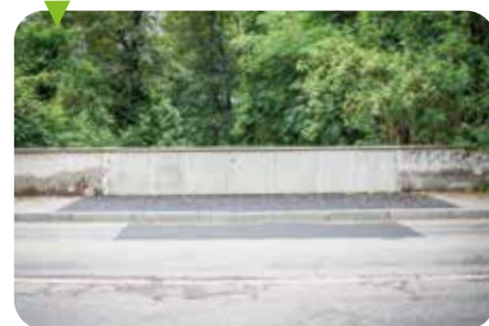
Route d'Éguisheim - Logelbach Réfection du trottoir, de la chaussée et du mur de séparation suite à un effondrement du trottoir.
