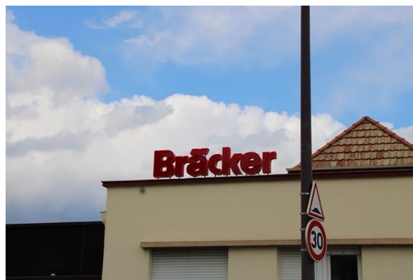
Enseigne sur toiture
