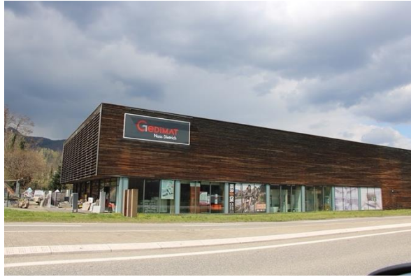
Enseigne sur façade (La Forge) et sur toiture (rue Clémenceau)
