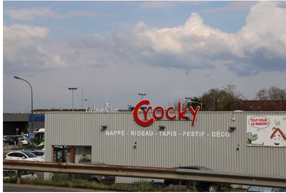
Enseigne sur façade illégale (dépasse de la façade)
