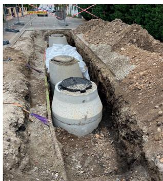
Pour pallier aux inondations récurrentes, des puits d'infiltration avec tranchées drainantes précédés de puits de décantation ont été mis en place dans la rue de l'Orme au point le plus bas avec dédoublement de l'avaloir et dans la rue du Bouleau.
