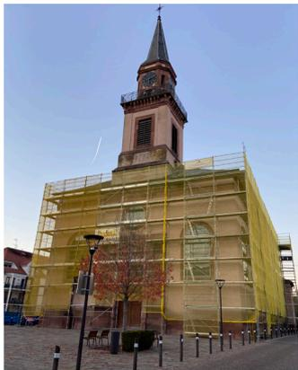
La réfection de la toiture devient nécessaire pour éviter des infiltrations dans les années à venir. Le chantier a démarré le 14 octobre 2021 par la pose de l'échafaudage et les travaux devraient durer trois mois.
