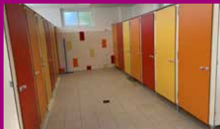
Les toilettes ouest de l'école La Dame Blanche rénovées par nos agents communaux
