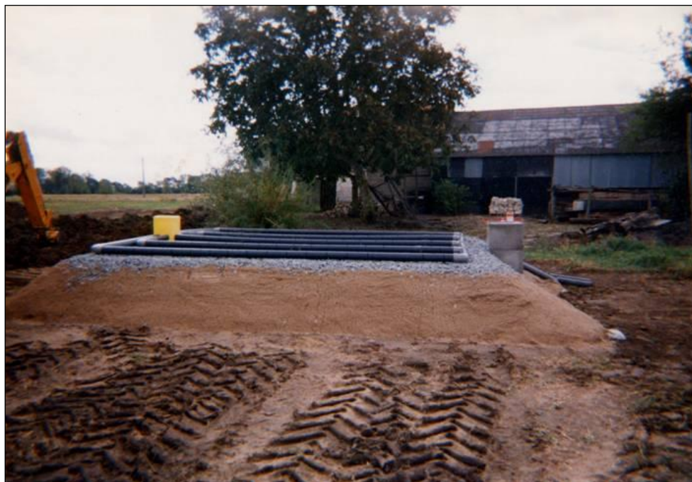
Travaux de mise en place d'un terte d'infiltration avant couverture
