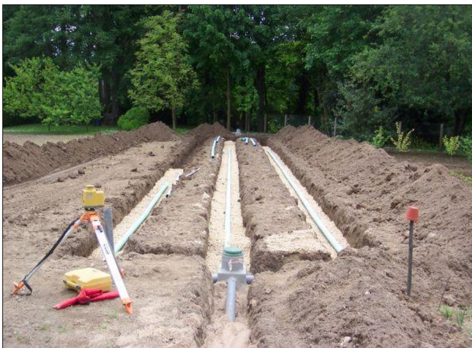
Travaux de mise en place de tranchées d'infiltration avant fermeture
