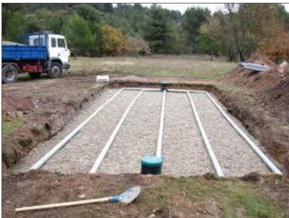
Mise en place d'une filière de type lit filtrant à faible profondeur
