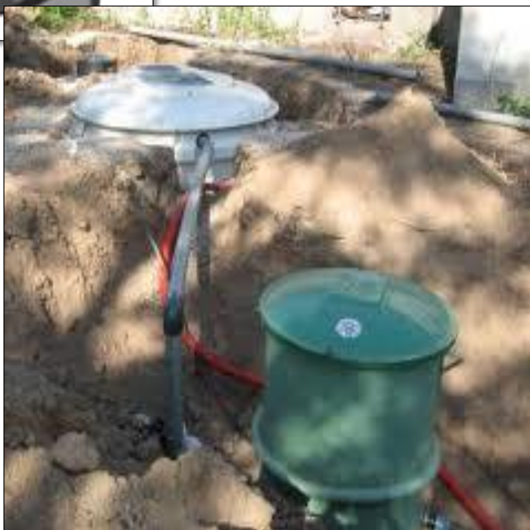
Mise en place d'un poste de relevage
