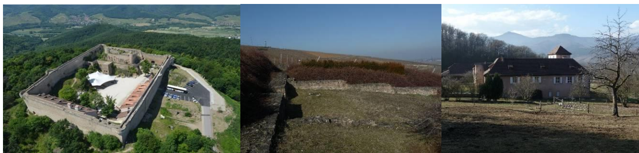
Château de Hohlandsbourg / Gîte d'étape romain / Ferme Saint-Gilles
